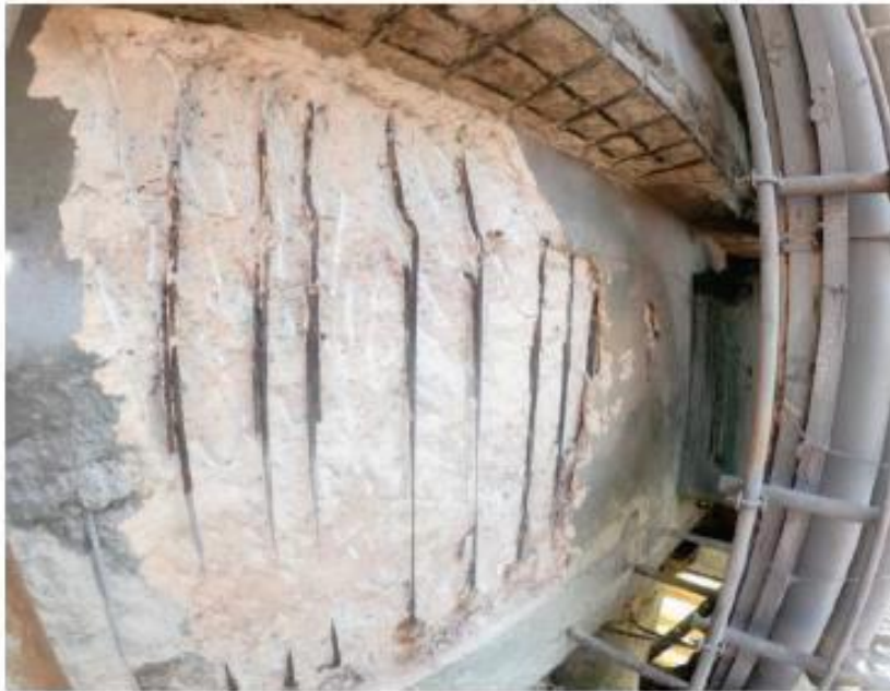
Figura 198 – Detalhe da demolição do concreto disgregado.
